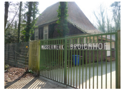
Wasserwerk Broichhof im Stadtwald
